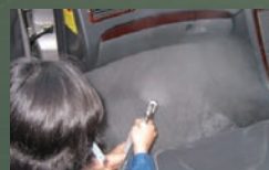
エアコン吸い込み口
